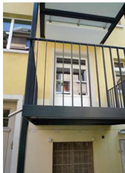
Neuer Balkonturm an der Pfirsichstrasse
