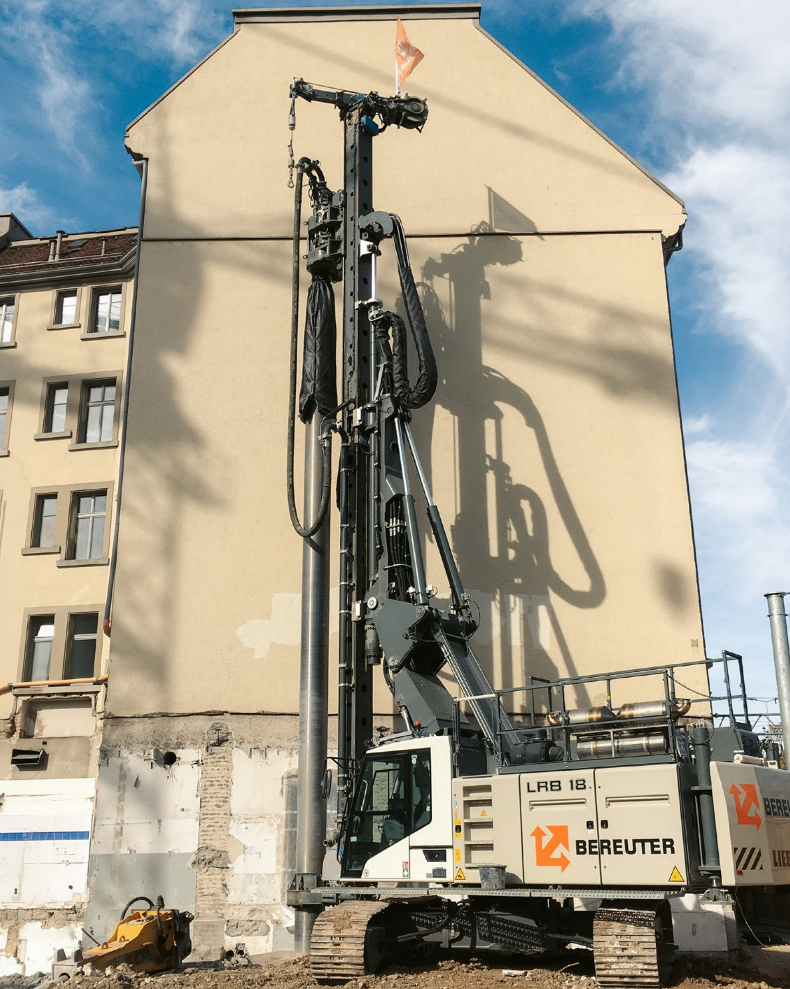
Rückbau der Rückwand – hier setzt der Erweiterungsbau an.
