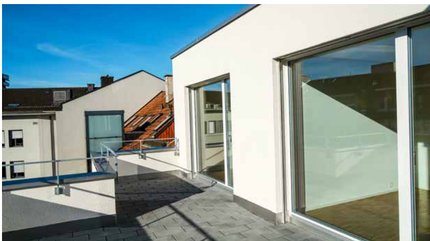
Die Bewohnerinnen und Bewohner werden die grosszügige Dachterrasse im Attikageschoss schätzen. Sie ist allerdings unter anderem wegen der Bauvorschriften entstanden.
