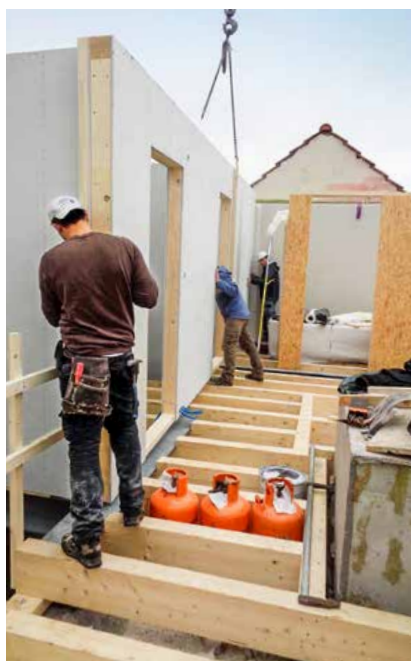
Für den Aufbau wurden die einzelnen Elemente vorgefertigt angeliefert.
