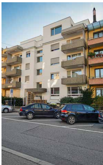
Das Haus an der Friesstrasse 35 in Zürich Oerlikon bietet dank der Aufstockung neu eine 10-Zimmer-Attikawohnung.
